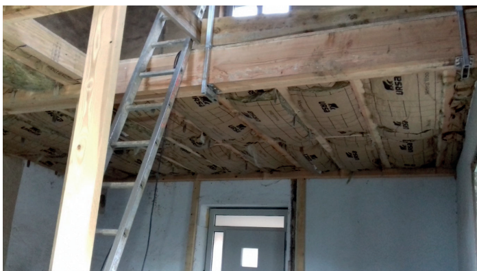
Pose de l'isolation, changement des menuiseries. ↗
