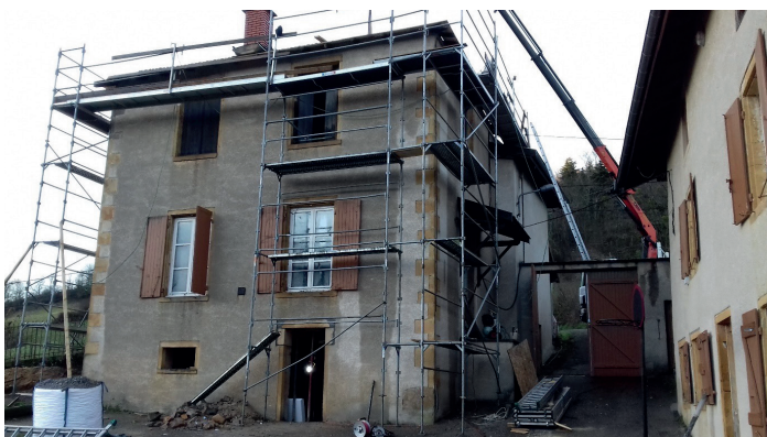
Changement de la toiture. ↗
