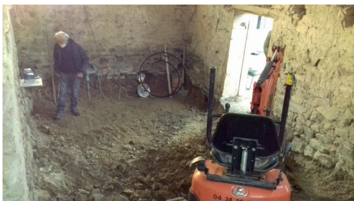
Décaissement de la partie basse ↗
