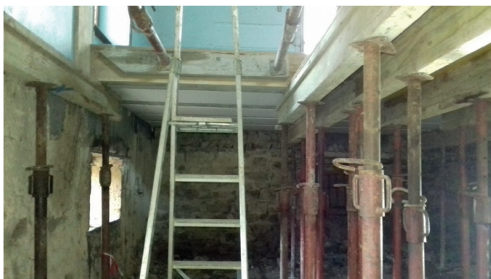
Coulage d'une dalle béton au 1 er étage ↗ et pose d'un plancher au 2 e étage.
