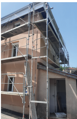
→ Isolation par l'extérieur, 20 cm de fibre de bois
