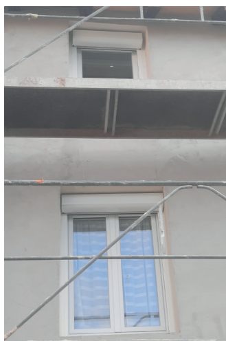
→ Pose des menuiseries extérieures avec volets roulants et VMC
