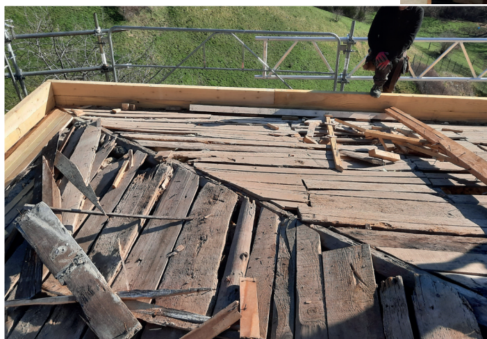
→ Remplacement des voliges
