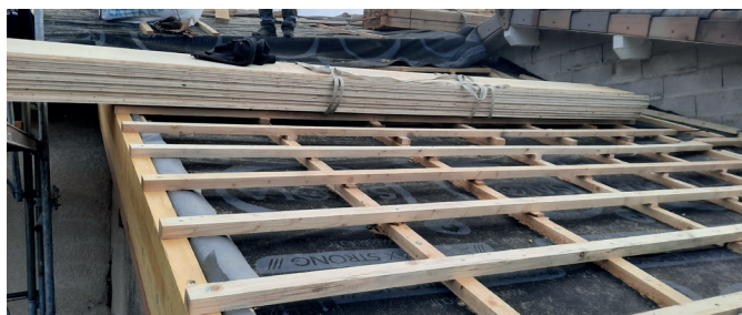
→ Pose de l'isolant, pare-pluie et tuiles neuves
