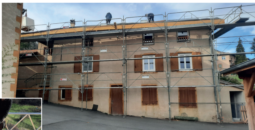
→ Pose d'un échafaudage
